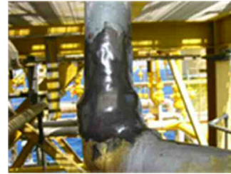
配管の油漏れを補修
