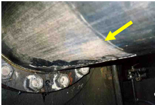
金属押し出し用フランジの補修
