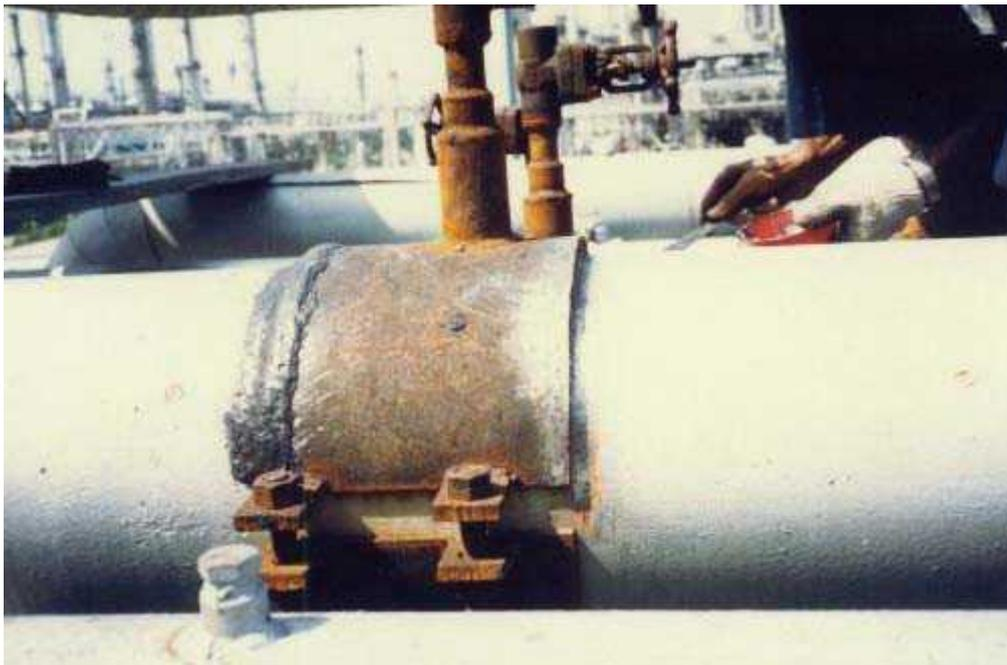
3本の水素配管をMM-メタルSS-スチールセラミックを使ってシールしています。水素は350psiで逃げやすくなります。圧力調整弁のついたメタルスリーブを用意します。MM-メタルSS-スチールセラミックをスリーブとパイプに塗ります。バルブが開いている間にスリーブを組み立てますので、水素が逃げやすくなります。MM-メタルSS-スチールセラミックが完全に固まった後、バルブを閉じて作動します。もし配管を交換するとしたら工場のライン全体を止めなければならなかったでしょう。
