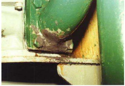
圧力のかかった給水管をMM-メタル UWと硬化剤UW3を用いて補修しています。水漏れしている状態でシーリングが 施されました。
