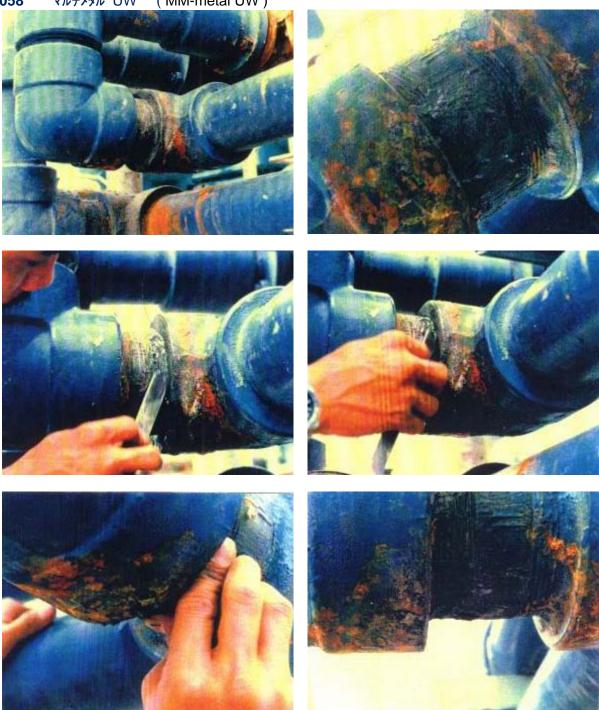
ハブルブ内蔵継ぎ手からの水漏れをMM-メタル UWと硬化剤UW3を使用して修復しています。 水漏れの原因は水と砂による腐食が原因でした。
